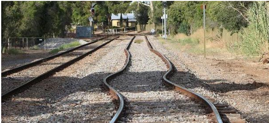
Figura 1: Foto de trilhos de trem deformados devido à alta temperatura.
